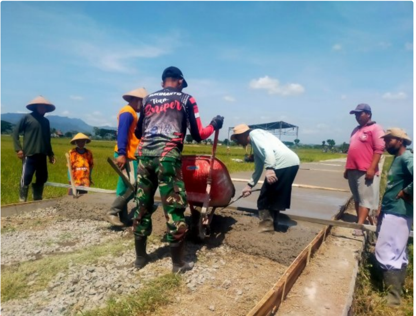
Kegiatan TMMD Sengkuyung Tahap IV Desa Pakisan Lakukan Betonisasi Jalan
