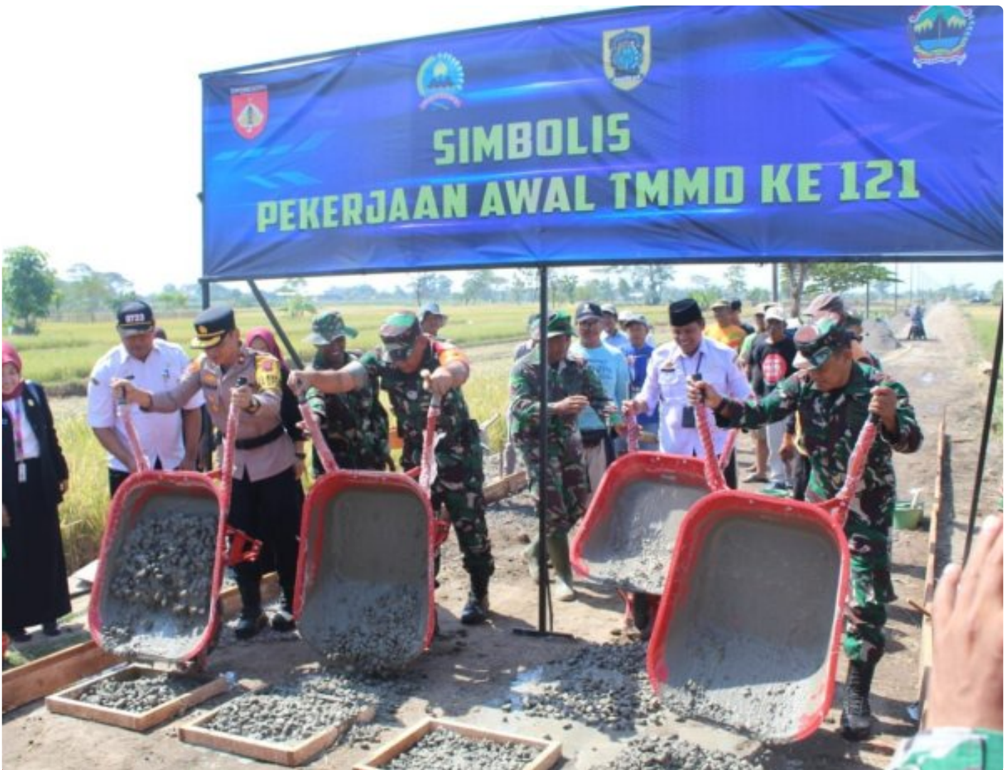
Pengecoran Perdana TMMD Reg 121 dilakukan Forkopimda Klaten
