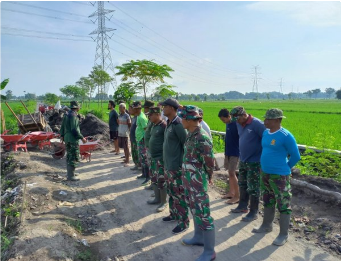
TMMD Desa Bero Trucuk Sasarkan Talud Sepanjang 710 M
